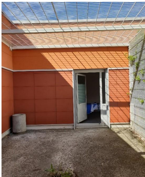
Cour de chambre d'isolement
