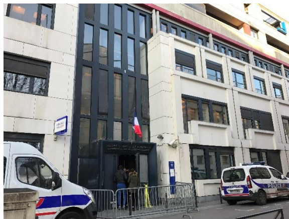
Façade entrée principale
