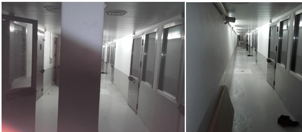
Cellules disposées de part et d'autre du mur central de séparation
