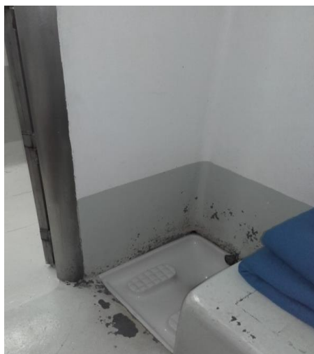
Cellule de dégrisement
