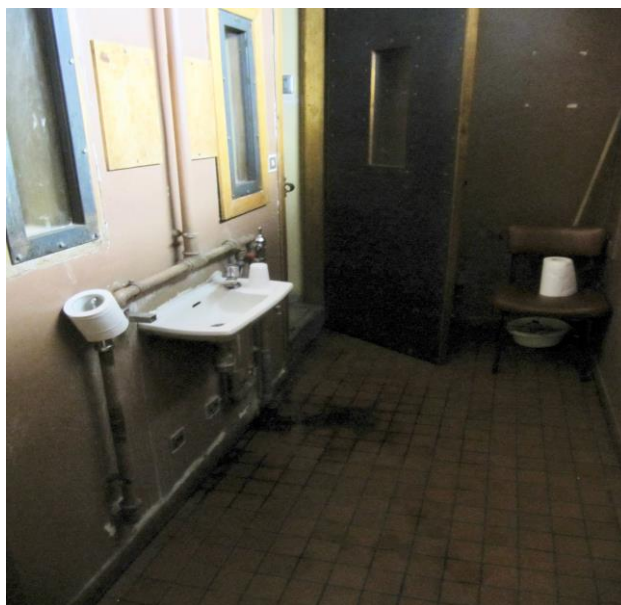
Lavabo dans le sas des deux cellules de dégrisement
