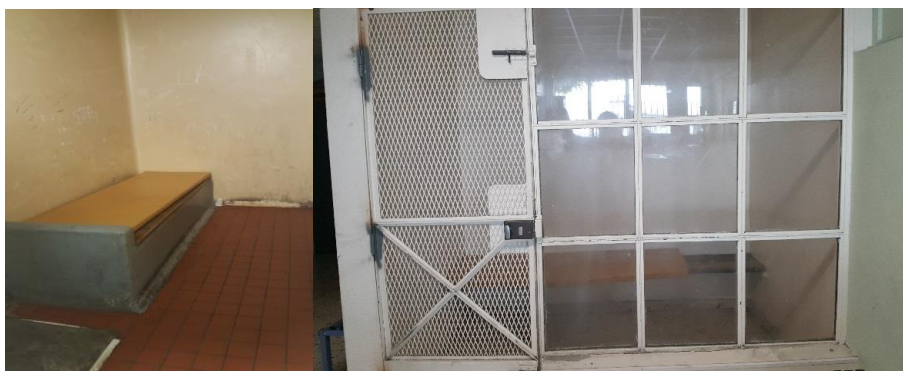
Geôle IPM transformée en cellule de GAV
