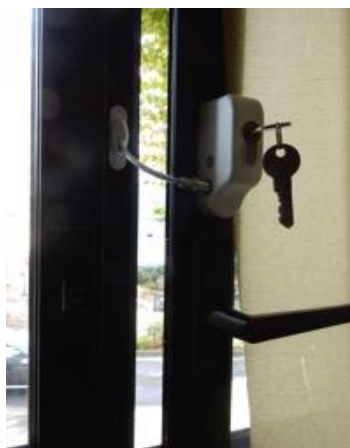
Figure 4 : sécurisation de fenêtre
