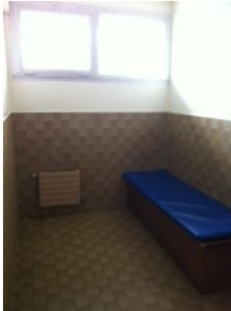
Le bat-flanc et la fenêtre de la cellule affectée aux mineurs
