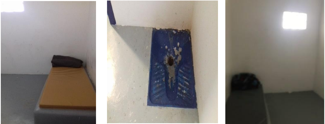
Le bat-flanc dans la cellule et la cuvette des WC à la turque
