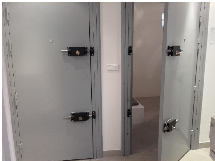
Vue des portes des deux cellules depuis l'antichambre
