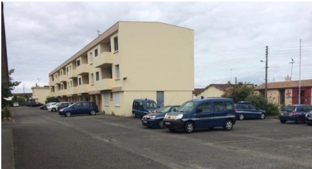
Figure 2 : les locaux à usage privatif derrière la caserne
