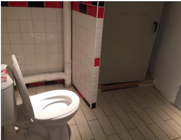
Figure 7 : WC réservé aux gardés à vue
