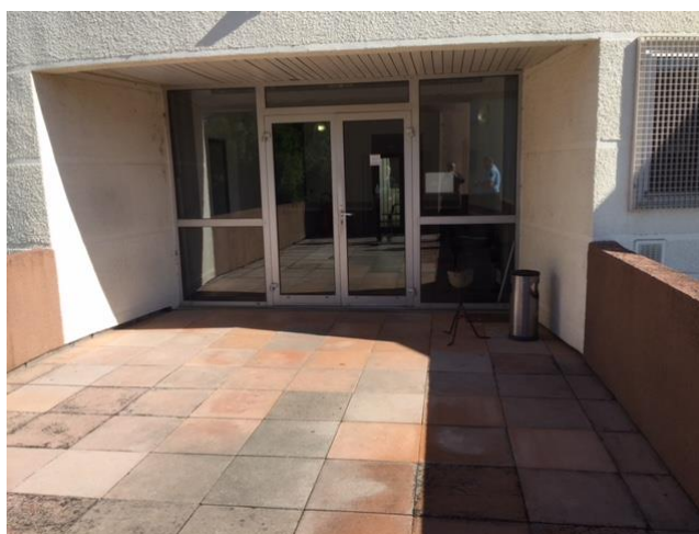
Figure 3 : entrée arrière de la caserne
