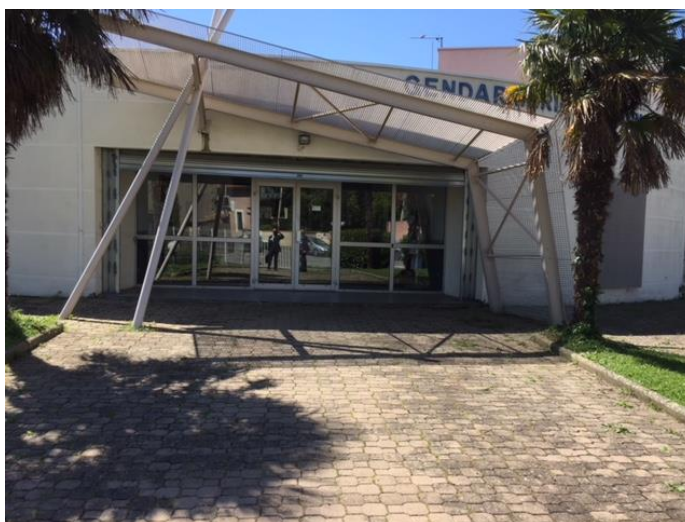
Figure 2 : caserne "Aspirant Lebaron" entrée du public
