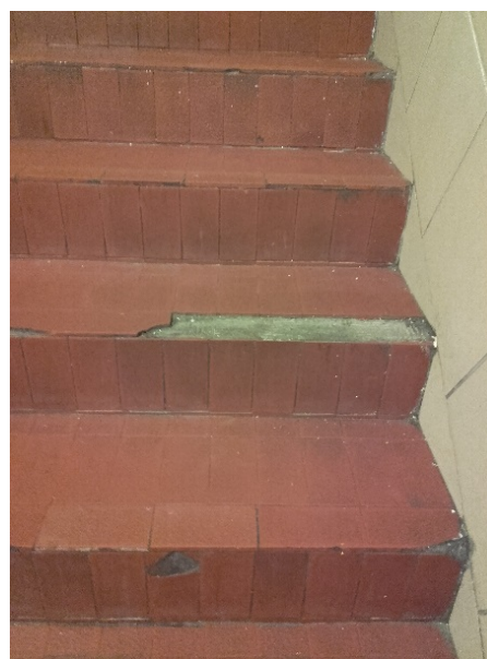
Escalier au sein d'une division
