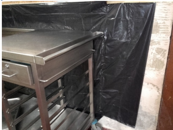
Plastique noir remplaçant le carrelage dans un couloir, travaux en cours
