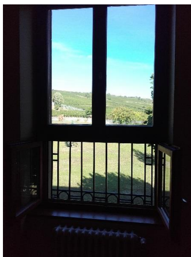
Bas de fenêtre ouvrante, barreaudée, et vue depuis une chambre de l'unité 18-2
