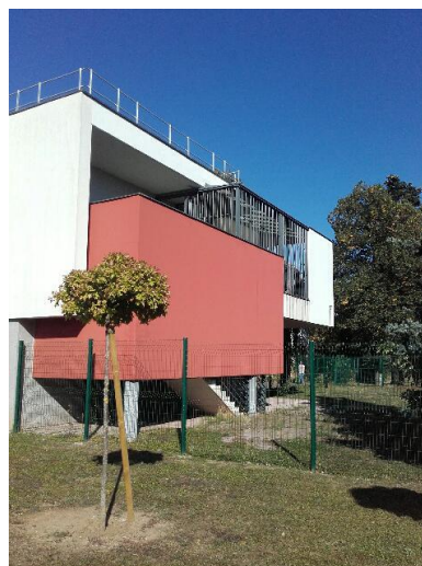
Fumoir de l'unité 23-2 vu de l'extérieur
