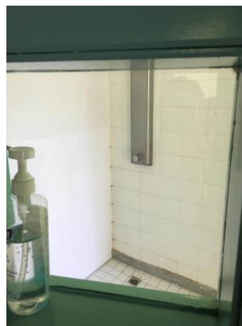
Douche d'une chambre d'isolement de l'unité 24-2, vue depuis le sas
