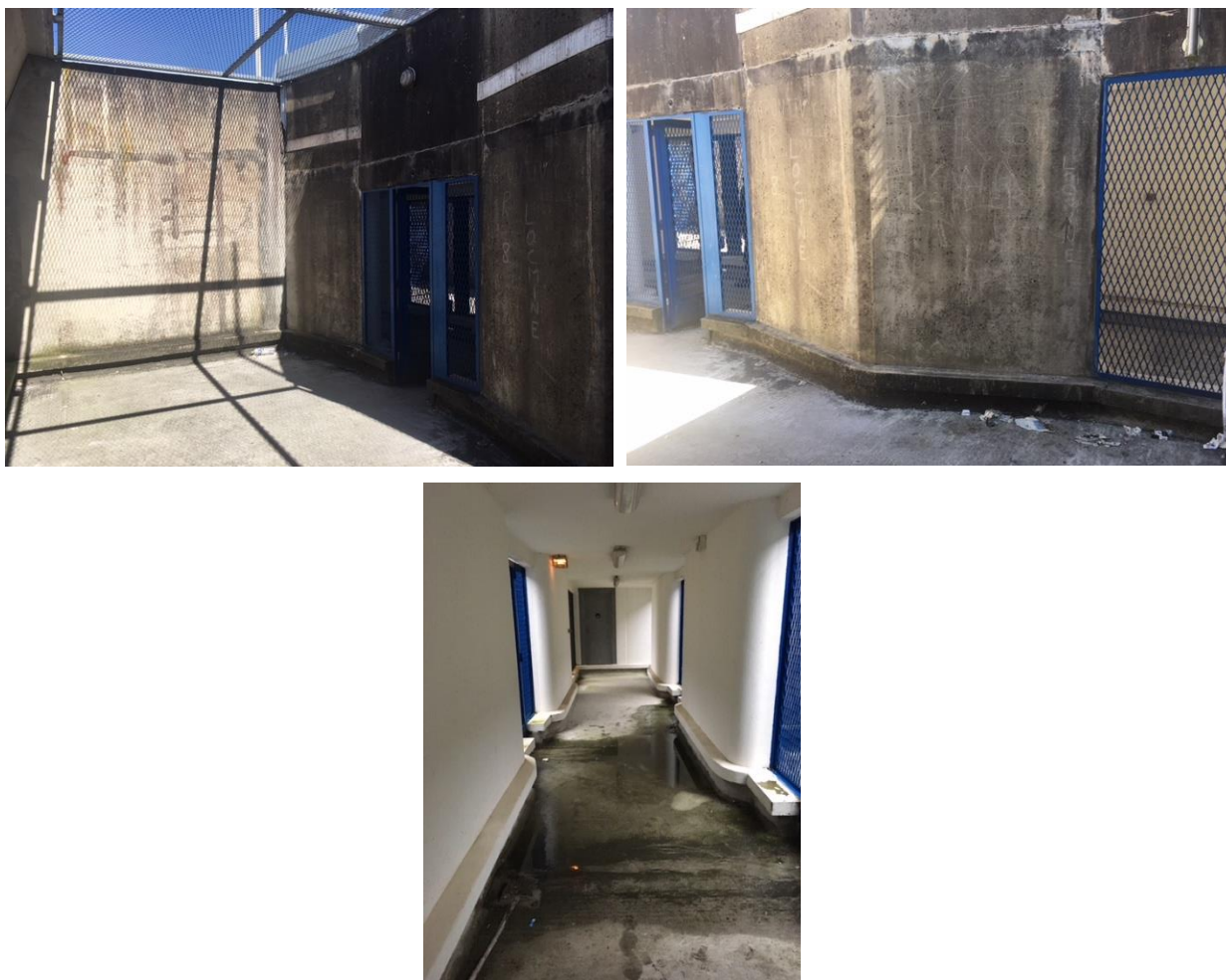
Vues de l'accès aux cours de promenade du QD-QI
