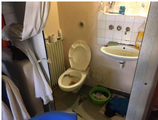
Coin sanitaire d'une cellule du QMA
