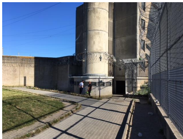
Accès de la cour de promenade et la guérite de surveillance
