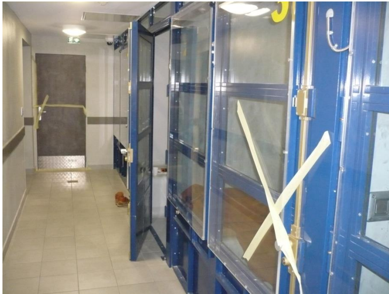
Couloir des locaux de sûreté (travaux inachevés)
