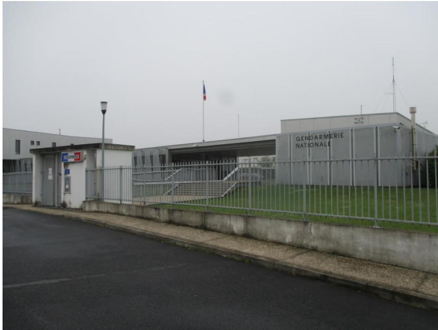
Vue de la BTA de Domont depuis le parking des visiteurs
