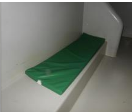
Bat-flanc et muret occultant le WC
