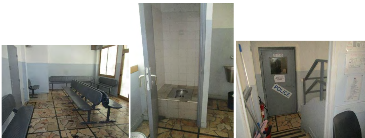
La salle d'attente, son WC et son point d'eau, l'accès à la salle d'attente
