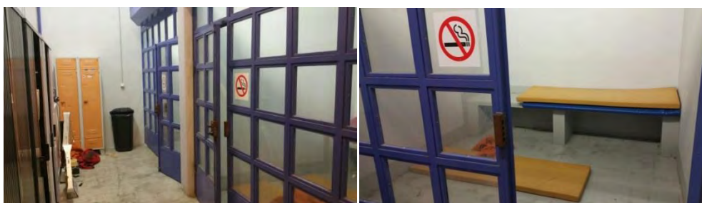
Le couloir et une des deux cellules
