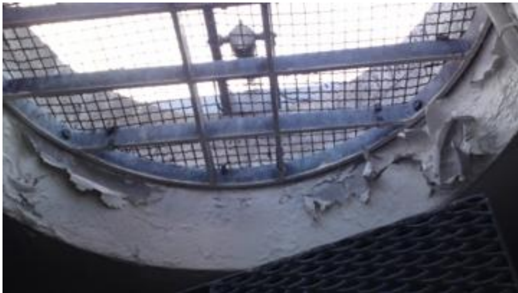
Le puits de lumière grillagé
