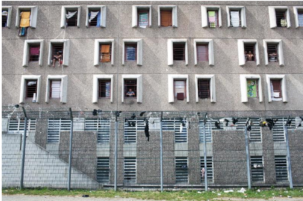
La façade du bâtiment B vue de la cour de promenade
