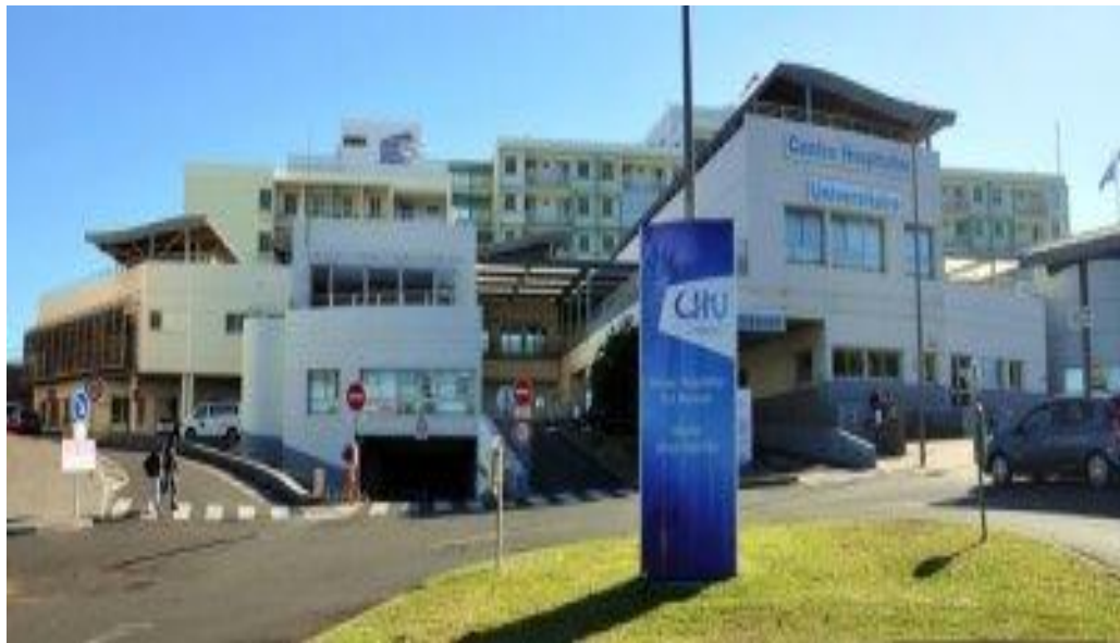
Entrée principale du centre hospitalier universitaire
