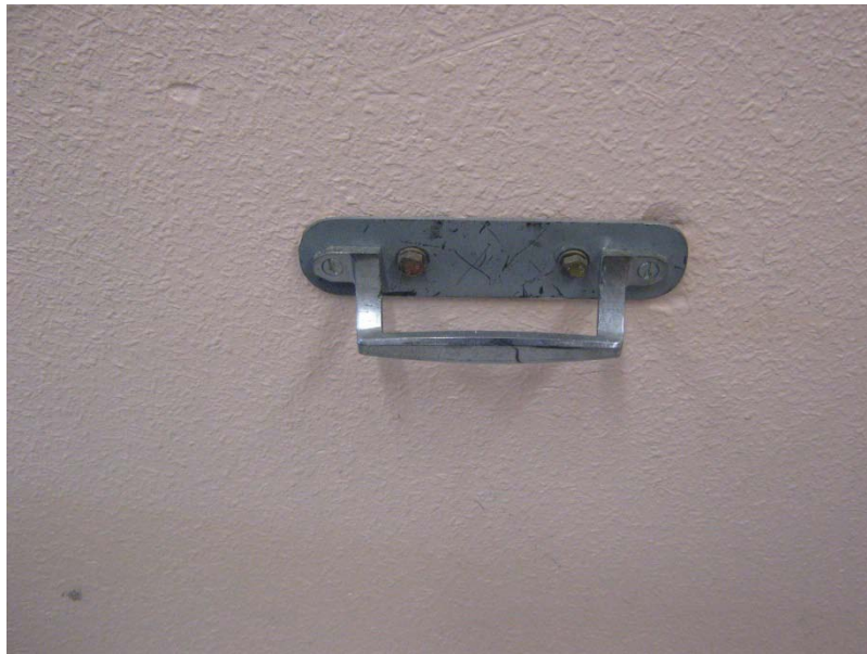
Poignée de porte fixée au mur pour servir de point d'attache
