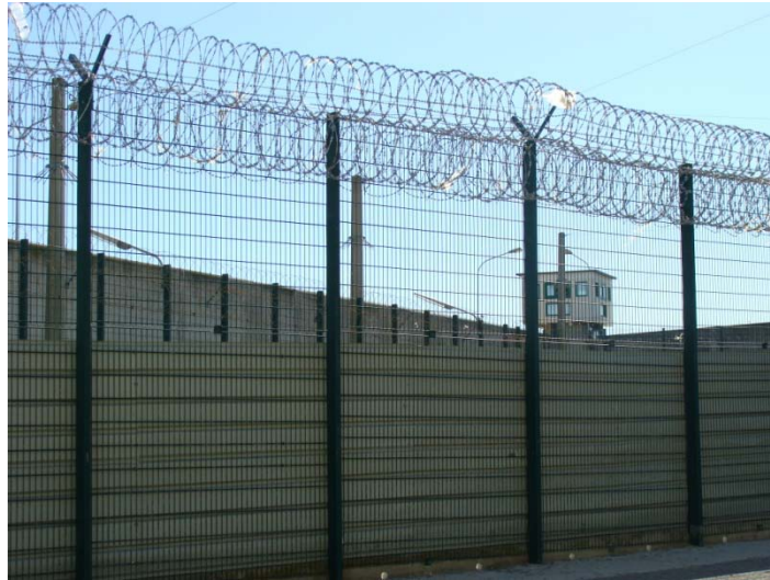
Dispositifs de sécurité de la cour du QM : grillage, concertina et mirador.
