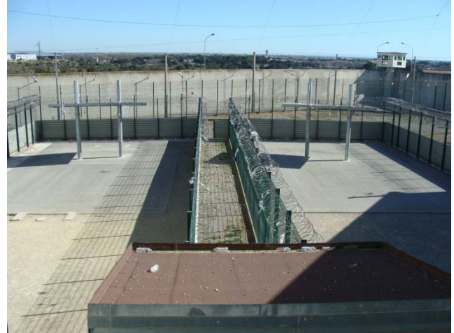
Proximité des cours dédiées aux majeurs et aux mineurs
