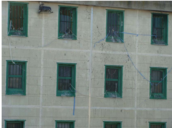
« Yoyos » aux fenêtres des cellules du quartier mineurs (en haut) et du quartier majeurs (au centre)
