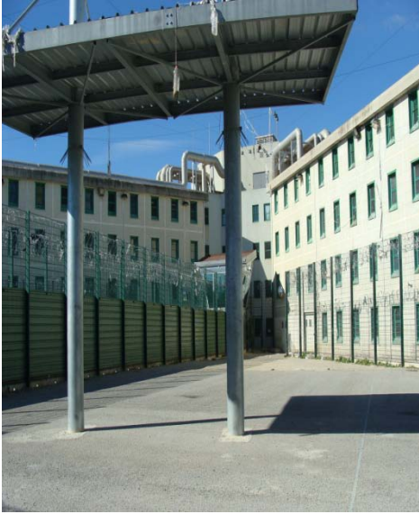
Cour de promenade située au pied du bâtiment de détention
