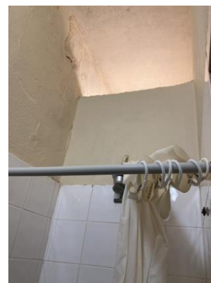
Cellule 24, plafond douche
