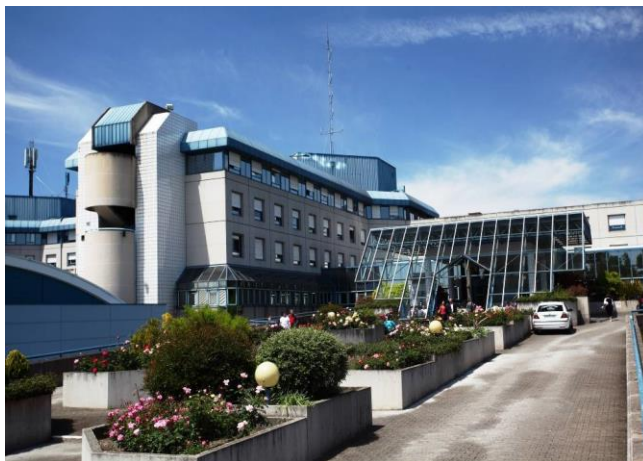
Entrée pour le public du centre hospitalier de Pau
