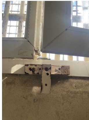
Système de fermeture de fenêtre par loquet en bois
