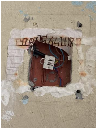
Fils électriques apparents
