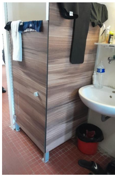
Cloison de l'espace WC
