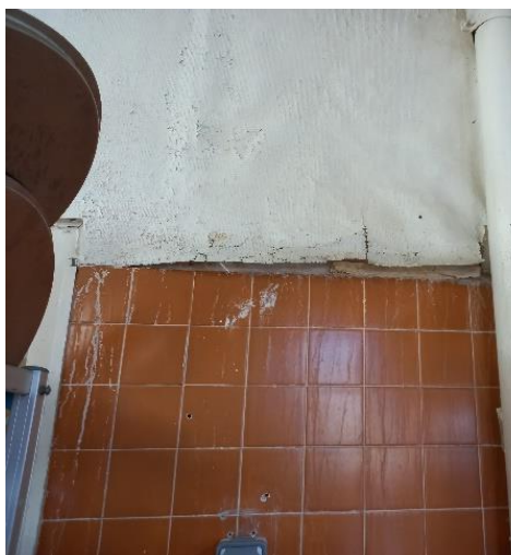
Détail du mur cuisine
