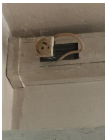
Gaine électrique d'une cellule non protégée
