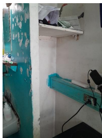
Système électrique et traces d'humidité
