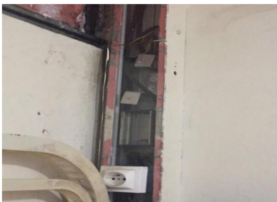
Gaine électrique d'une cellule non protégée
