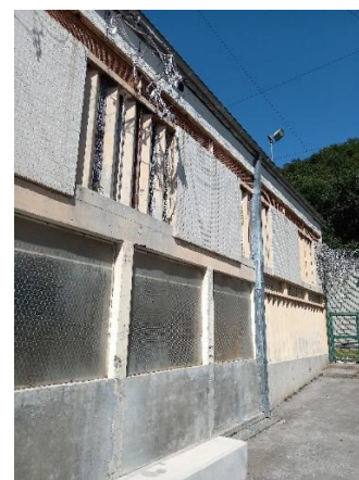
Le mur côté cour
