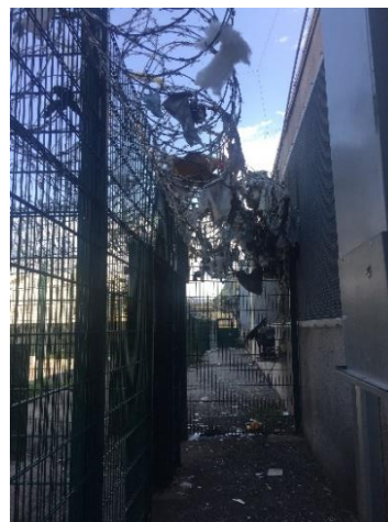
Débris jetés par les fenêtres
