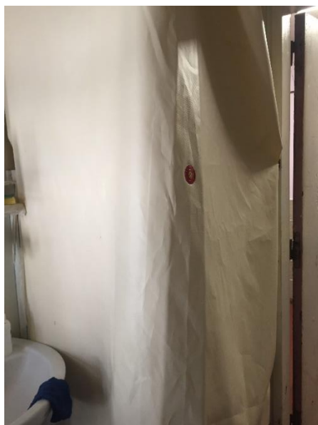
Bâche plastique protégeant l'espace des WC
