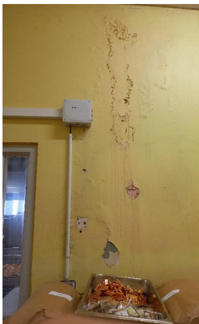
Zone des chariots de cantine dans le couloir
