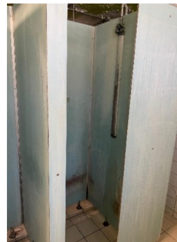
Douches utilisées comme local de fouille dans les coursives
