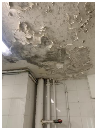
Plafond des douches collectives
