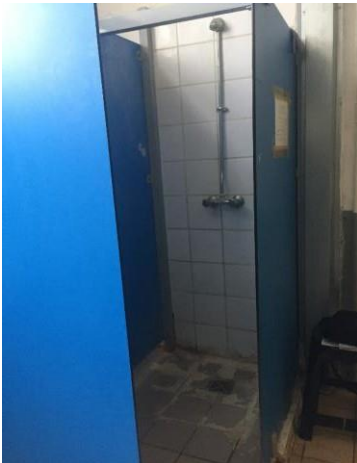
4 douches collectives palier 1er étage petit quartier
