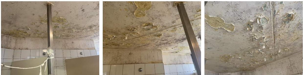
Plafonds de douches collectives au bâtiment B
