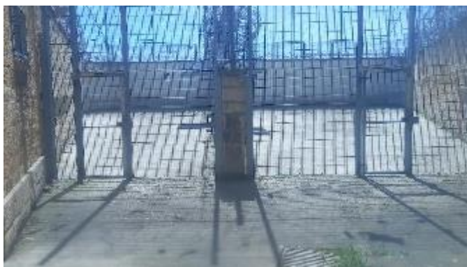
Vues des cours de promenade 1 et 2
