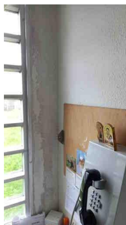
Vues de cellules simples du bâtiment D avec traces de moisissure, fenêtre mal jointée et sanitaires non isolés
