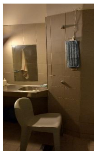
Installations précaires dans les douches des cellules PMR, absence de siège de douche adapté
