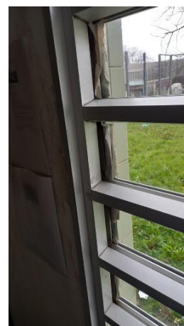
Vues de cellules simples du bâtiment D avec traces de moisissure, fenêtre mal jointée et sanitaires non isolés
