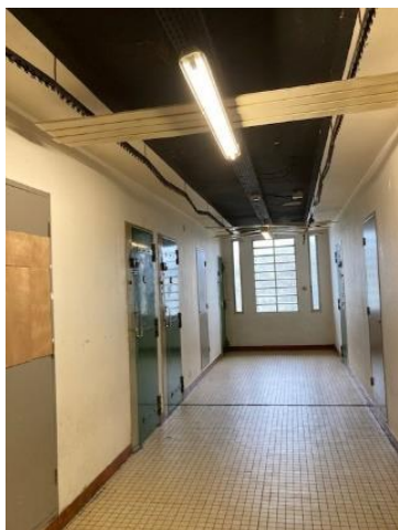
Couloir dépourvu de faux plafond
