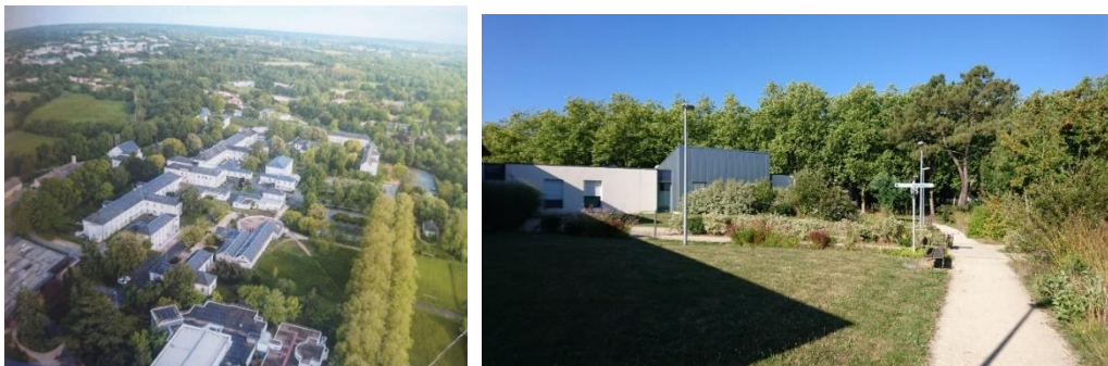
Vue aérienne du site, et circulation aux abords de l'unité Littoral 1
