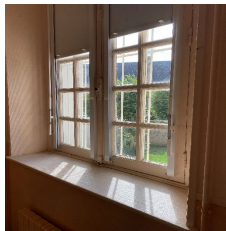
Fenêtre verrouillée et avec barreaux
