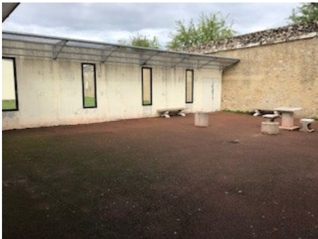
Cour de l'unité à laquelle ont accès les détenus maintenus en chambre d'isolement
