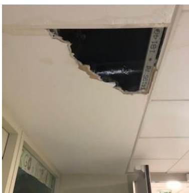
Double plafonds, G06, rdc
