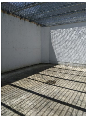
Vue d'une d'une des cours de promenade
