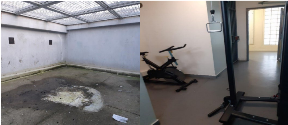
Cour de promenade et salle de sport du quartier d'isolement
