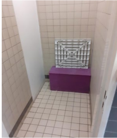
Local de fouille du vestiaire
