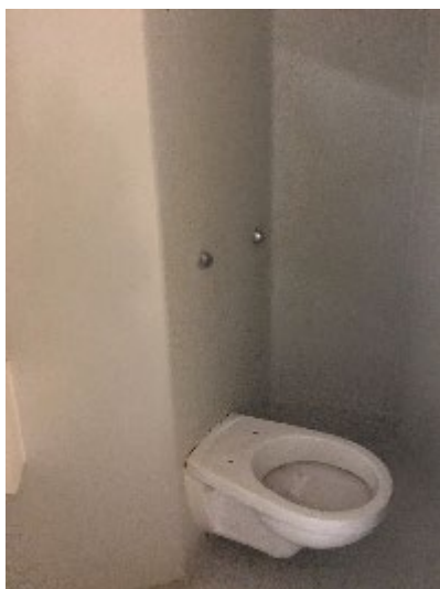
Les WC-douche de la cellule
