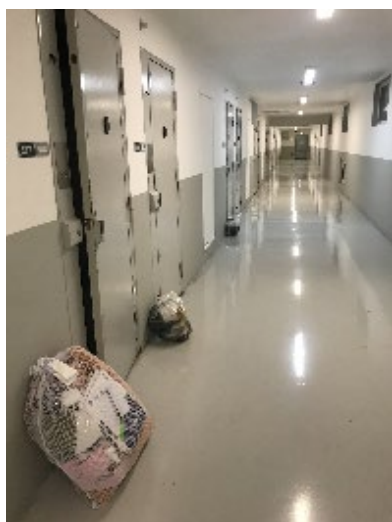
Le couloir du QA
