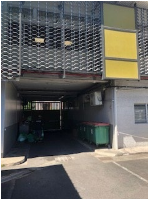
Vue du portail d'entrée des véhicules de police
