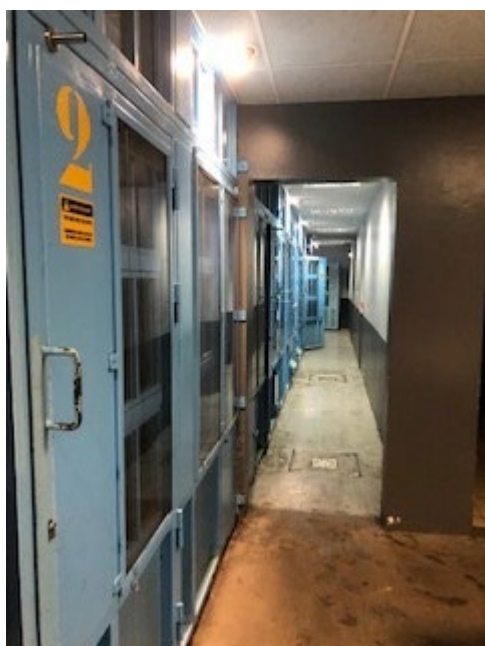
Vue du couloir donnant sur les cellules
