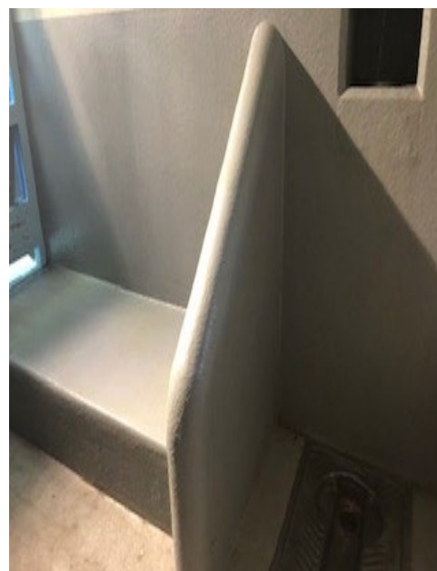
Vue d'une petite cellule de garde à vue
