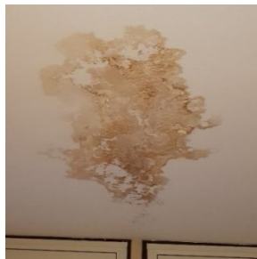
Infiltrations d'eau au plafond du pavillon C
