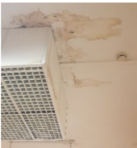
Infiltrations d'eau au plafond du pavillon C
