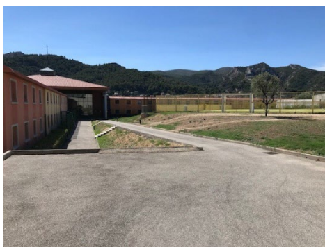
Vue du couloir ouvert de circulation vers les unités 0, 1 et 2
