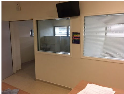
Vue des chambres sécurisées depuis le poste de surveillance
