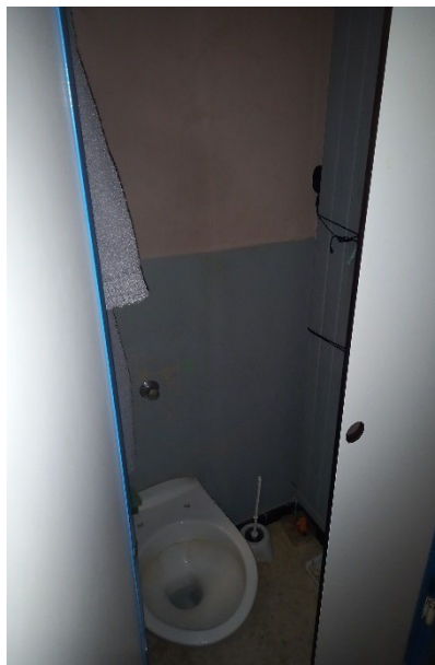
Sanitaire d'une cellule simple
