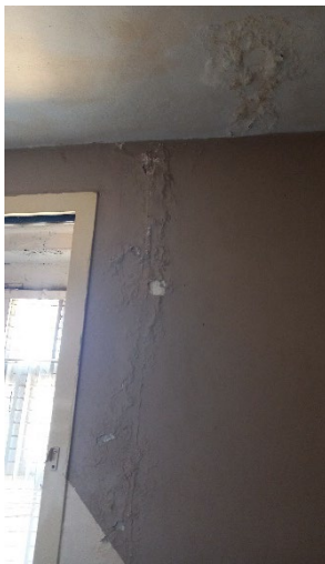
Moisissures au plafond et sur les murs de la cellule n°130
