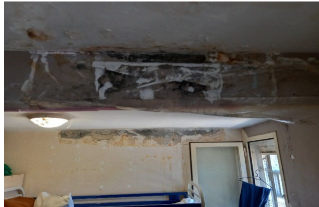
Moisissures au plafond et sur les murs de la cellule n°130
