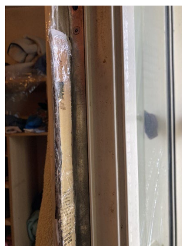
Réparation du joint de fenêtre avec du carton
