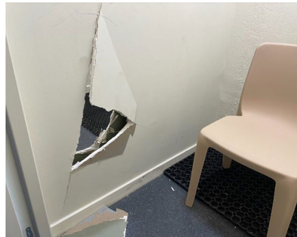
Box de fouille en division 2
