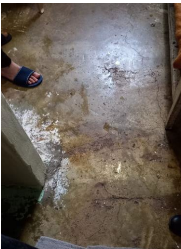
13 Sol de cellule, ouest
