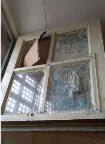
10 Fenêtre de cellule, ouest
