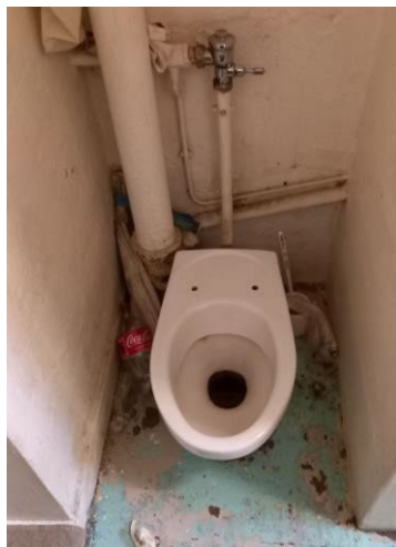
14 WC en cellule, ouest
