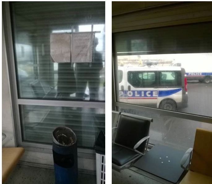
Photos 5 et 6 : les volets roulants des fenêtres du sas
