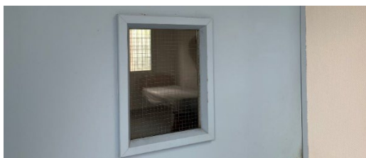
Fenestron d'une porte de chambre
