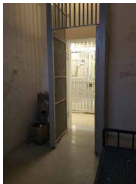
Aménagement d'une cellule du QD
