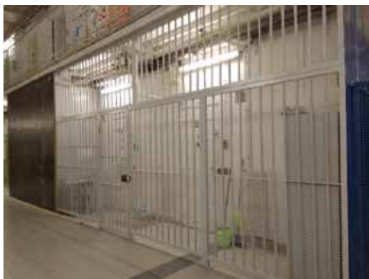
Vue du quartier disciplinaire au rez-de-chaussée de la détention
