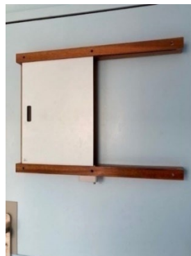
Fenestron d'une chambre fermable
