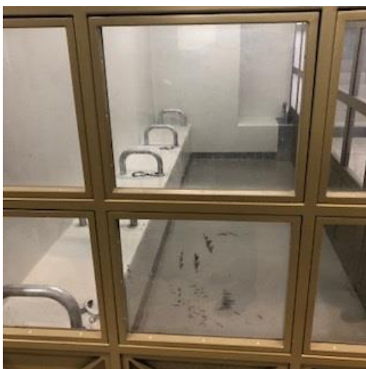
La salle d'attente vue du poste de surveillance
