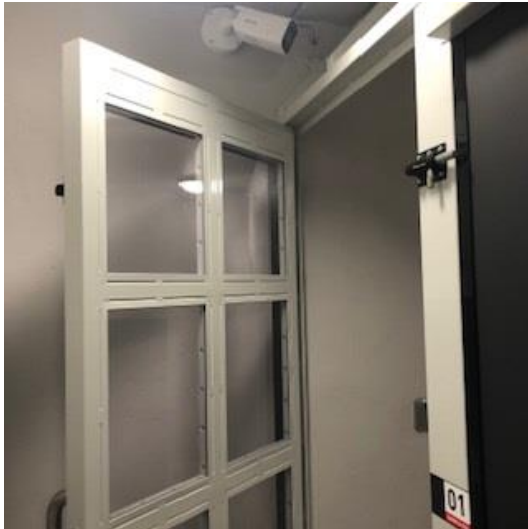
Le petit couloir et l'entrée de la première cellule de dégrisement
