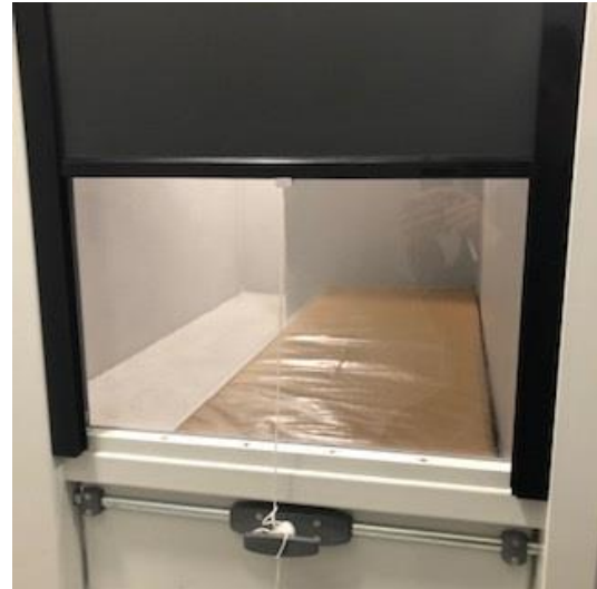
La première cellule de dégrisement avec vue du muret de séparation des WC
