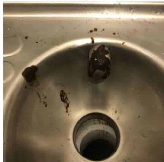
WC souillés non nettoyés entre deux personnes accueillies
