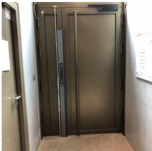
La porte extérieure du sas réservé à l'entrée des personnes interpellées
