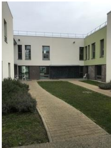
Vue des bâtiments unités Rdc et 1
