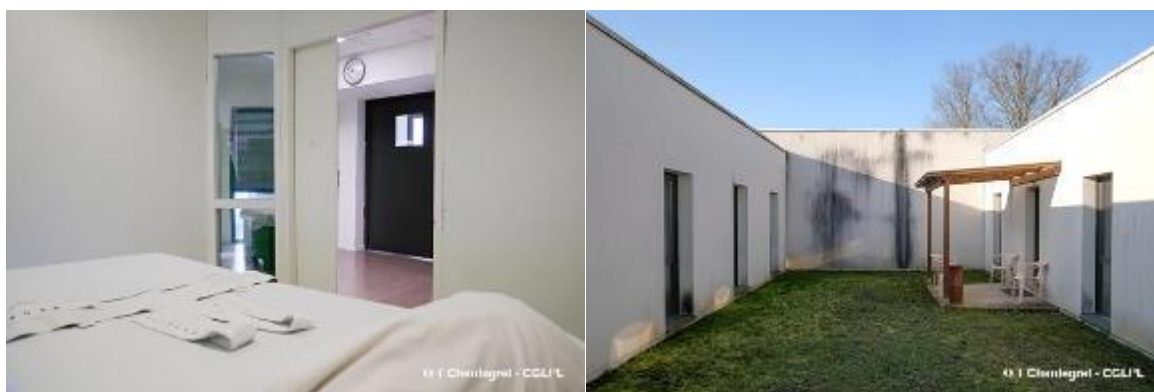
Chambre d'isolement et patio au Pré-Poitiers
