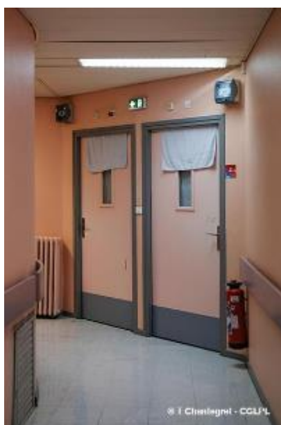
Portes des chambres avec fenestron
