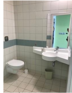
Salle de douche
